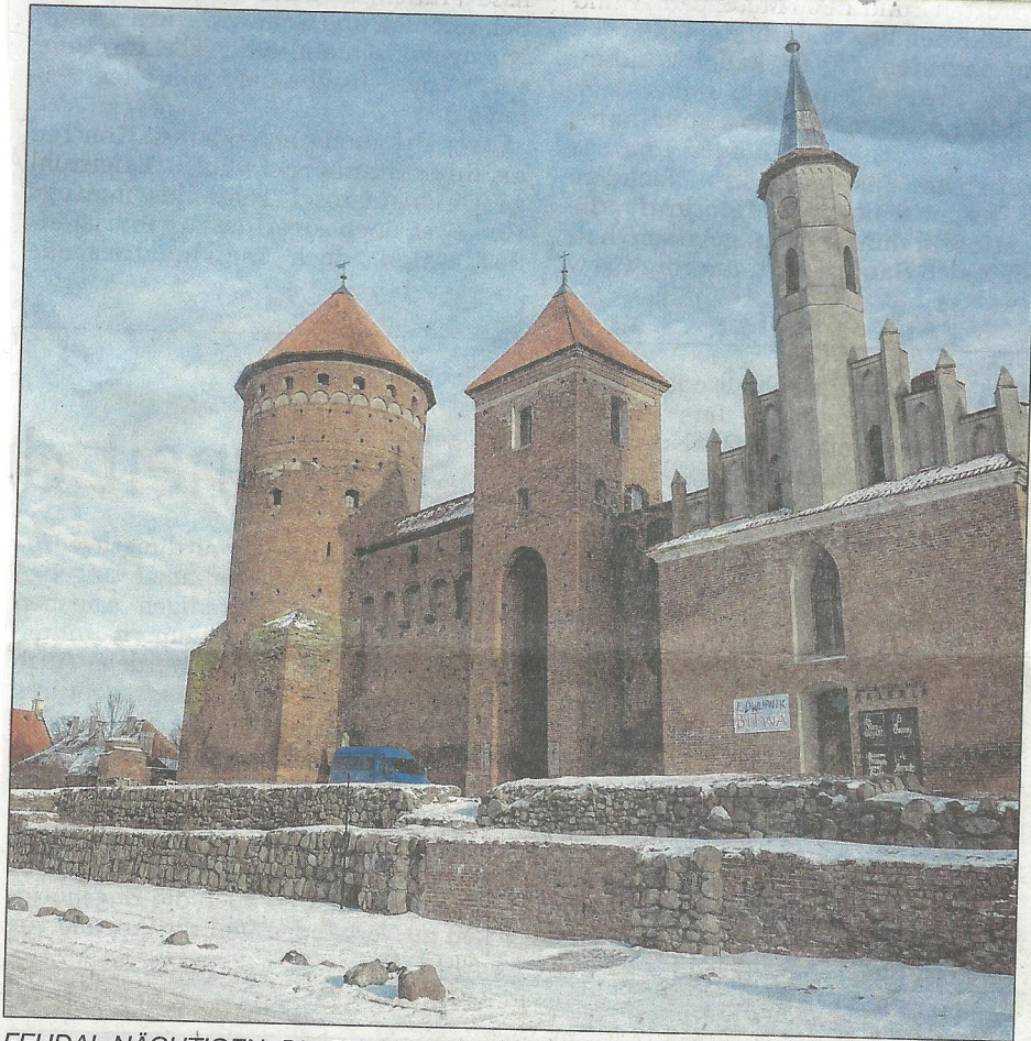
FEUDAL NÄCHTIGEN: Die Bischofsburg von Reszel ist fast 700 Jahre alt. Vor einigen Jahren wurde sie zu einem Hotel und Tagungsstätte umgebaut. Fotos: Sturmhoebel
